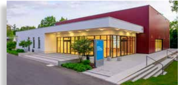
Der Multifunktionssaal des Bayerischen Rundfunks auf dem Gelände an der Wallensteinstraße.
